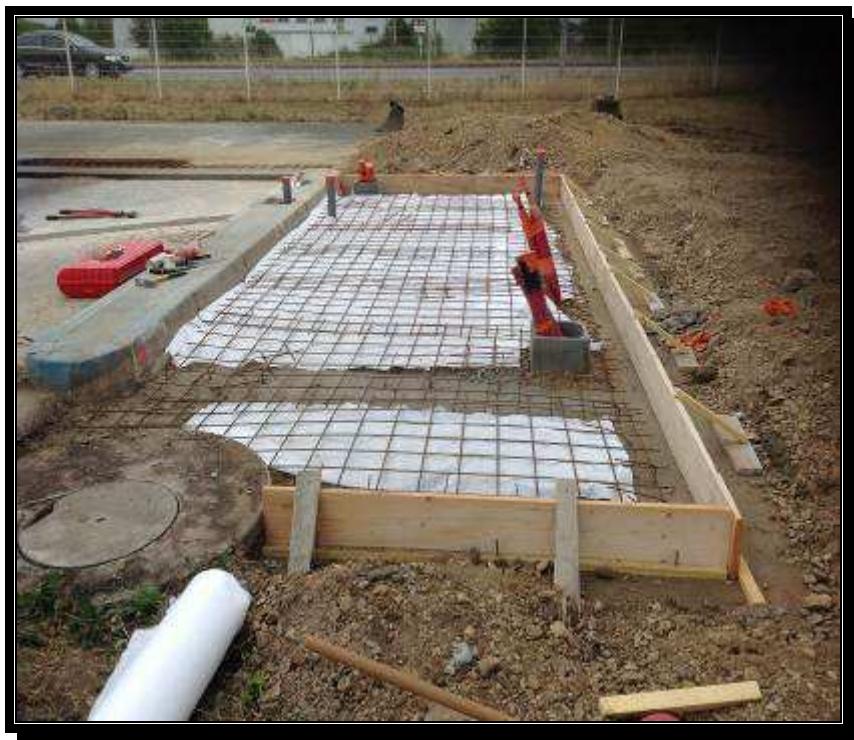
Réalisation d'une dalle pour le local technique
