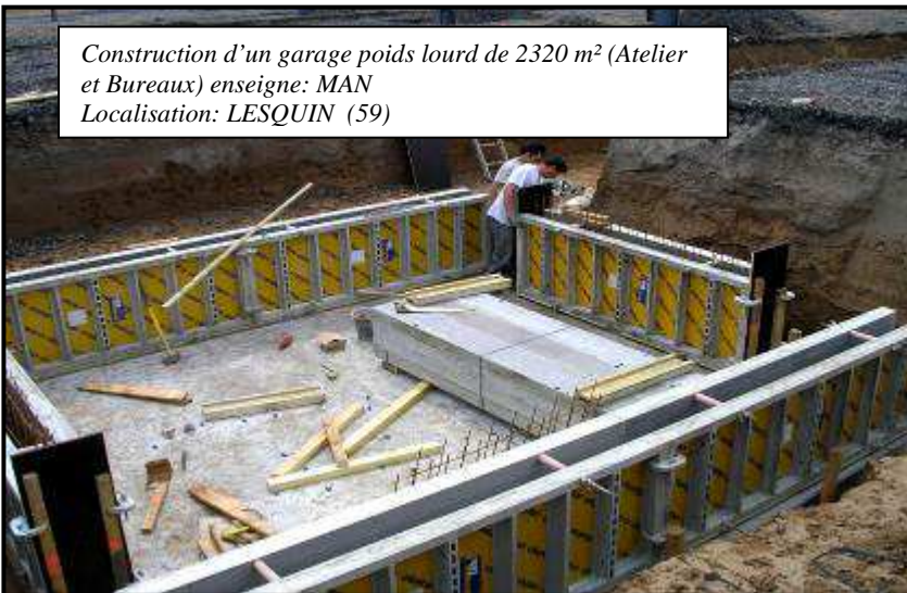
Mise en place d'une Fosse-banc de freinage préfabriqué
