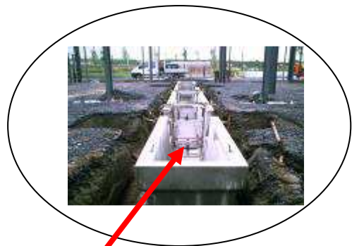
Mise en place d'une Fosse-banc de freinage préfabriqué
