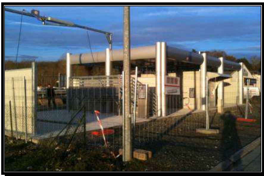
Génie civil station lavage 2 pistes couvertes + une découverte avec plateforme
